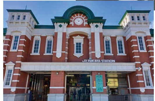
渋沢が起業した機械式煉瓦工場の煉瓦を使用した東京駅を模した深谷駅
