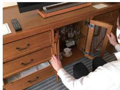
車いすに乗ったままでも手が届くよう高い位置にあった食器棚を下へ。足元にもスペースを確保
