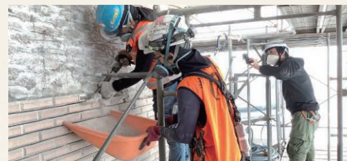
弥栄会館の外壁タイル保存作業
